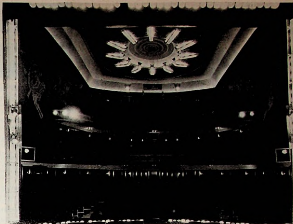
De schouwburgzaal met alle lichten aan. Aan de uiteinden van de balconen ziet men de nieuwe schijnwerpers met de er omheen gebouwde bakken. Links en rechts de kooflampen, die nog bij de toneelverlichting van de zaal uit behoren. Geheel achter bovenaan nog twee schijnwerpers, gemonteerd naast de filmcabine.
